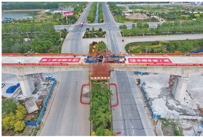
京滨铁路宝坻特大桥跨街连续梁合龙
