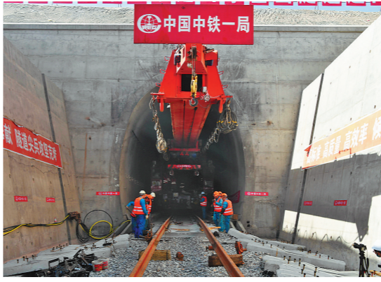
图为钢轨铺通阿尔金山隧道。
