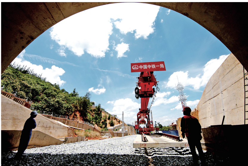
新运公司6月3日安全平稳铺轨通过中老铁路国内段第一座全长944米的桥和隧道。 通讯员 刘顺良 摄影报道
