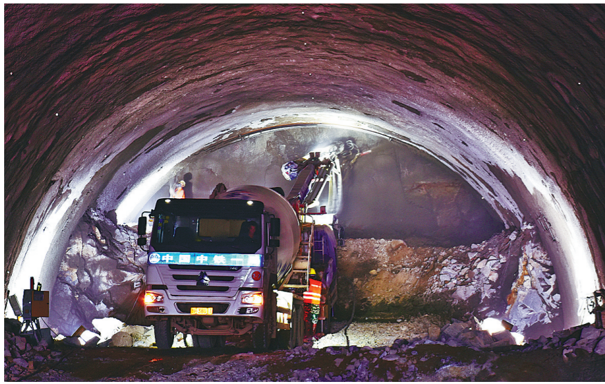
隧道初期支护喷浆机械手作业。
