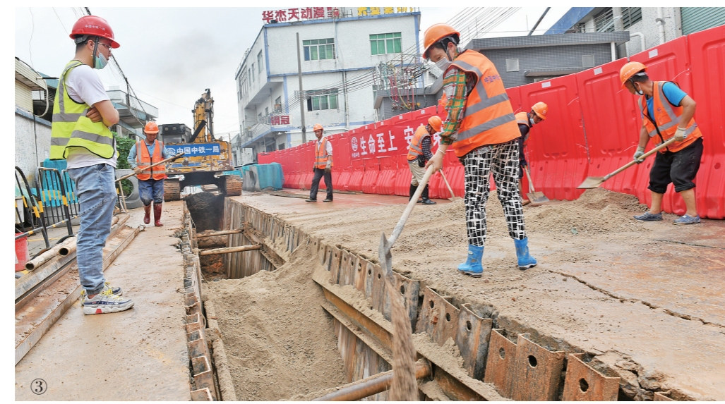
图1为“木棉脚”公交站附近工点,作业人员在机械开挖沟槽后,做好钢板桩支撑。 图2为项目管理人员认真值守,现场盯控管渠开挖施工。 图3为作业人员在坑头村工点进行分层回填基坑。
