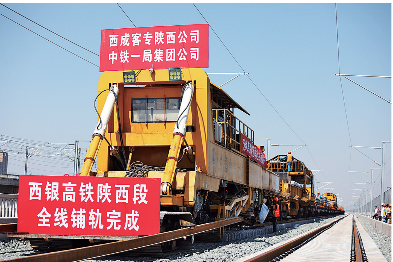
铺轨机将最后一根长钢轨平稳安放在轨枕上。
