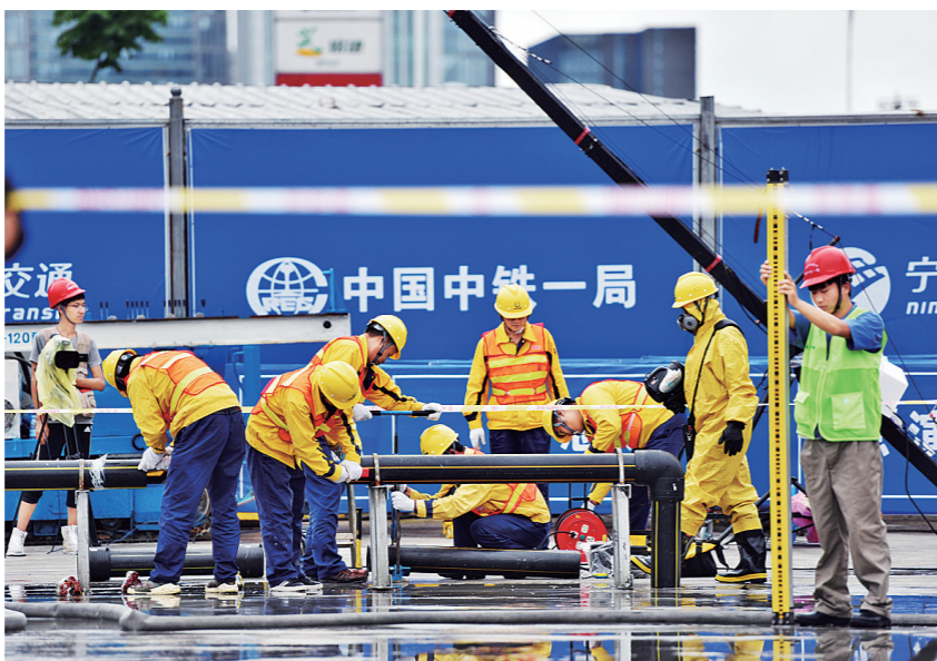
演练现场管道维修。
