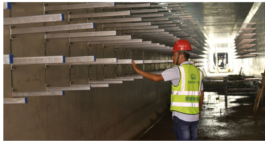
图为检查托架安装质量。 牛荣健 摄
