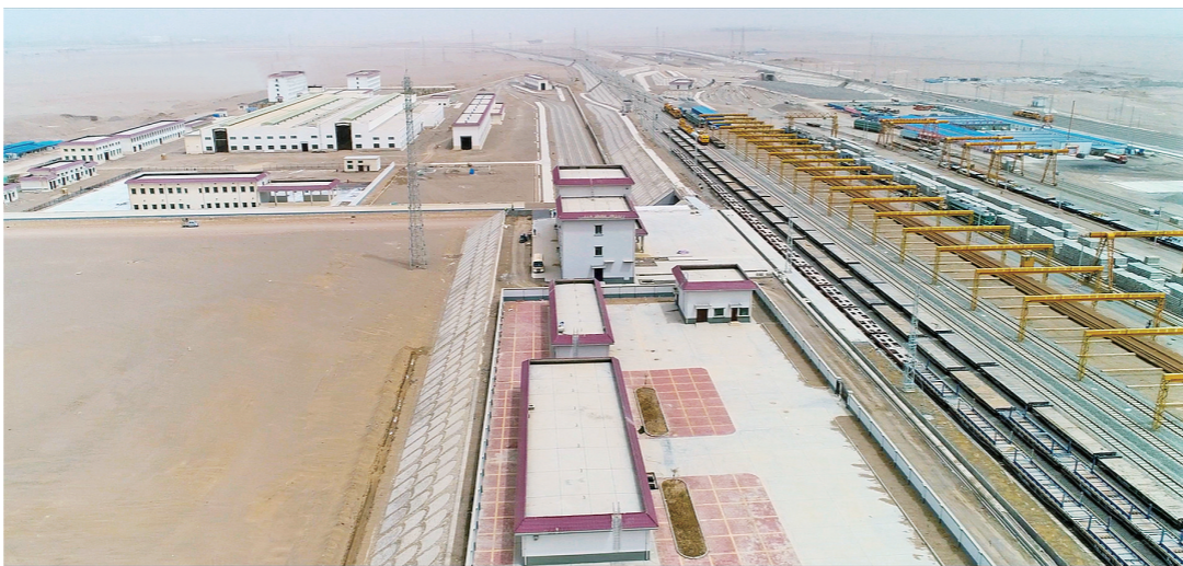
图为中铁一局承建的格库铁路格尔木南枢纽站场。
