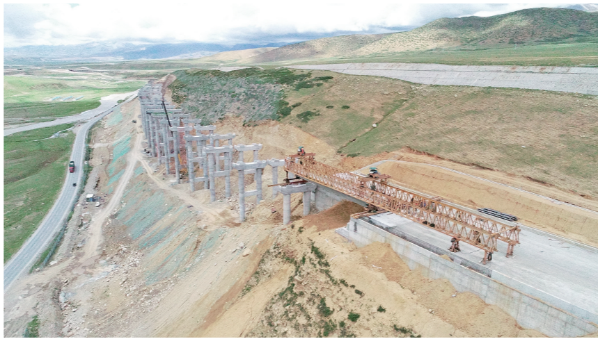
中铁一局三公司承建的西藏那羊公路重难点、控制性工程堆巴果大桥首片30米箱梁7月4日顺利完成浇筑,为完成公司和业主年度施工任务和节点目标奠定了坚实的基础。图为架梁现场。
