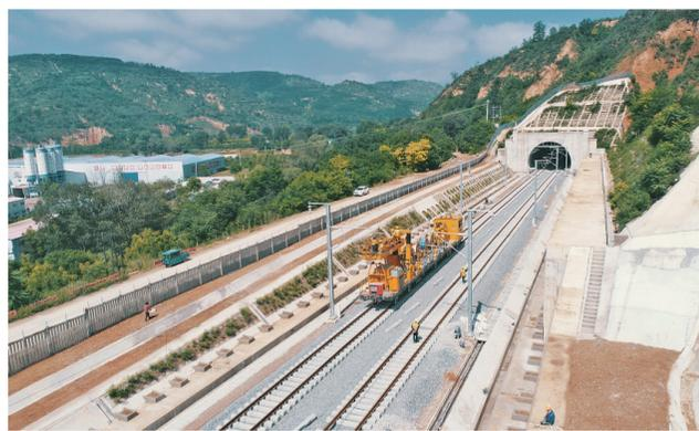
7月26日，随着银西铁路宁县车站第1、2接触网锚段导线架设到位，标志着由中铁一局承建的站后“四电”工程进入收尾攻坚阶段。图为恒张力放线车正在宁县车站进行接触网导线架设。 通讯员 尚永超 刘陈 李瑶 摄影报道
