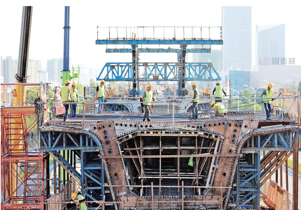
上图为马庄特大桥悬臂连续梁钢筋绑扎。左图为台州市域铁路S1线一期工程开发大道站至银泰城站区间连续梁等主体已完成。 王利 摄
