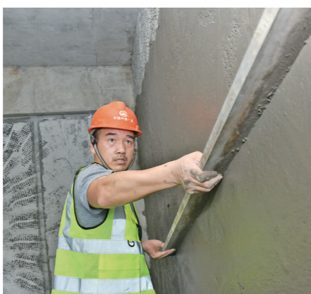
①建设中的歌笛湖项目楼层外,标准规范的外架安全防护设施。 ②项目坚持标准化施工,作业人员正在进行室内抹灰作业。 ③项目领导班子现场研究方案,解决超高层施工难题。 (图片摄于2020年8月)
