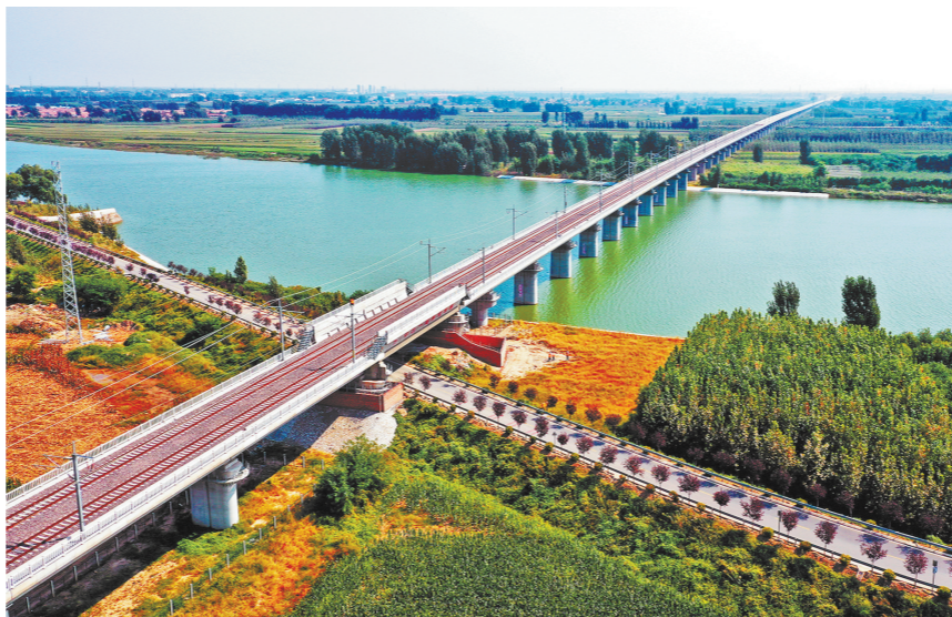
五公司承建潍莱高铁潍河特大桥。
