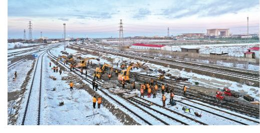
12月24日14时, 随着宽轨场和换装场 最后2组道盆的顺利 插入,小机捣固作业的 完成,标志着由中铁一 局新运公司承建的霍 尔果斯口岸站扩能改 造工程主体施工任务 顺利完成,按期兑现乌 鲁木齐局集团公司站 场启用节点目标。
