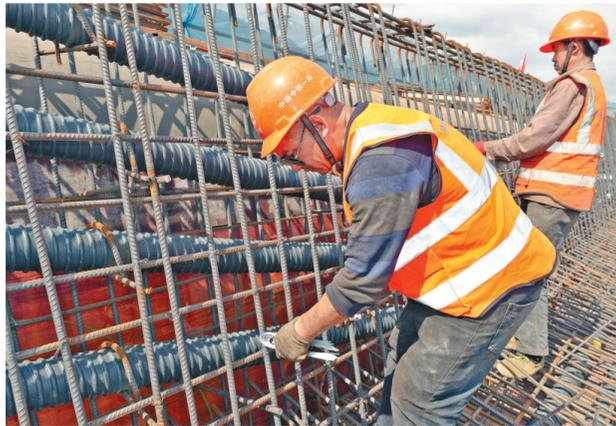
B匝道B2~B5联锁应力现浇箱梁盖板钢筋绑扎。
