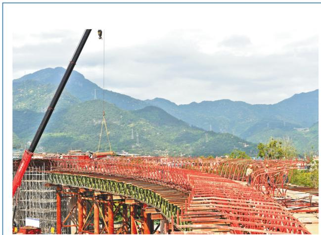
B匝道B5~B8联锁应力现浇箱梁翼缘板支架安装。
