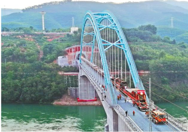
5月9日,随着一对500米长钢轨的缓缓落地,经中铁一局新运公司玉磨铺架制梁项目部员工的奋力拼搏,中老铁路国内玉磨段铺轨首跨澜沧江,顺利通过景洪澜沧江双线大桥。
