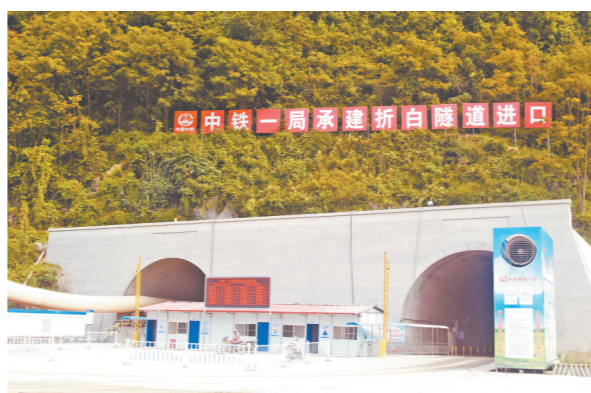
折白隧道进口。
