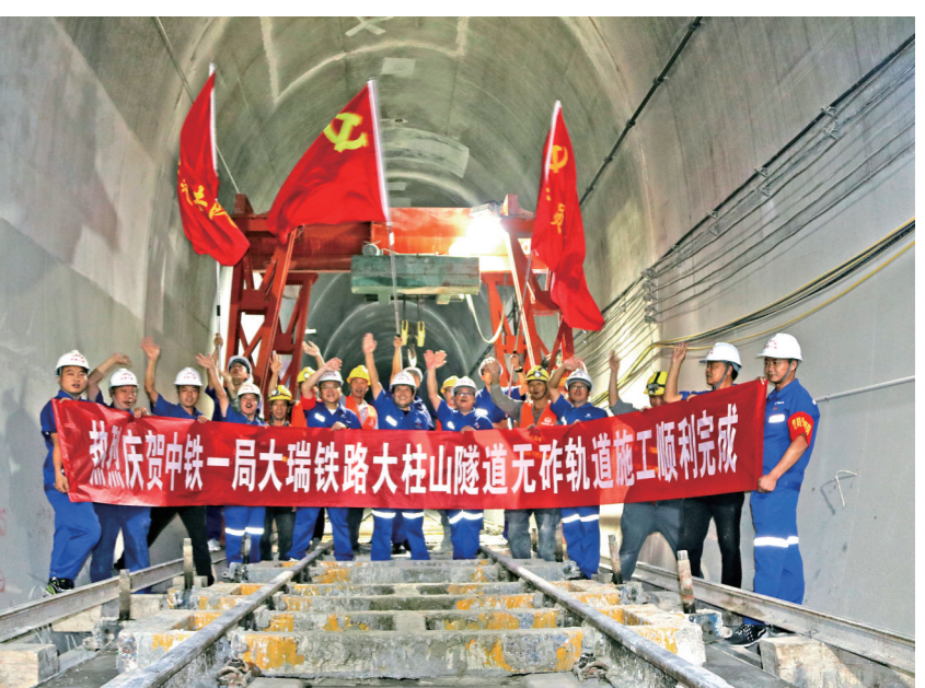
庆祝无砟轨道施工顺利完成。
