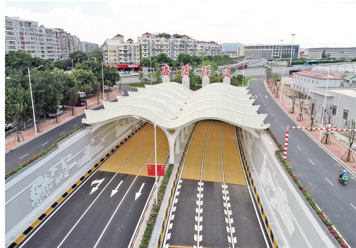
图为中铁一局承建海沧隧道湖里端出口。
