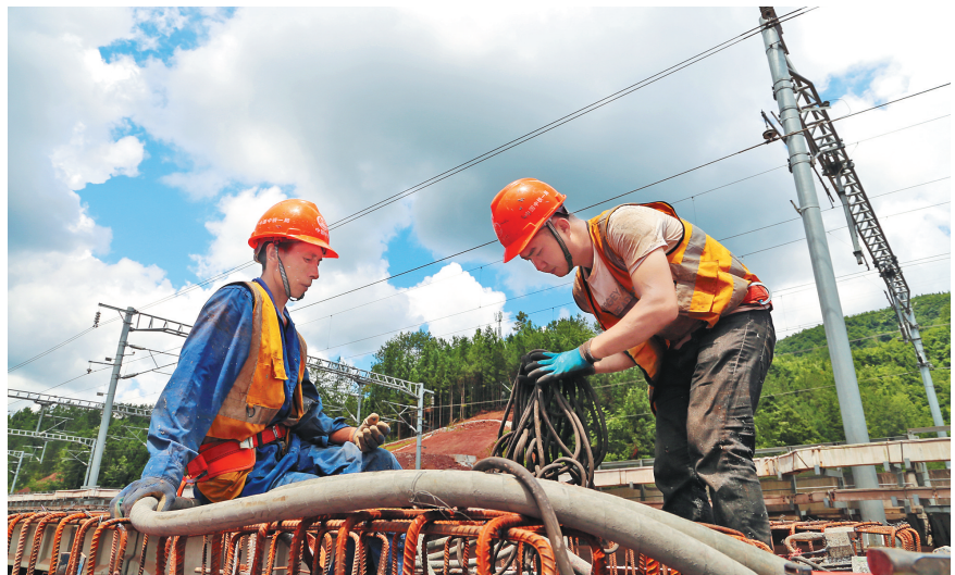
图为现场作业的工人。
