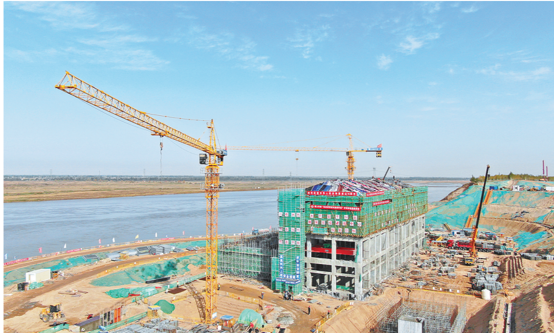
银川都市圈城乡中线供水工程取水泵站封顶,整合并取代原有多个小型泵站的功能。 本报记者 侯若斌 摄
