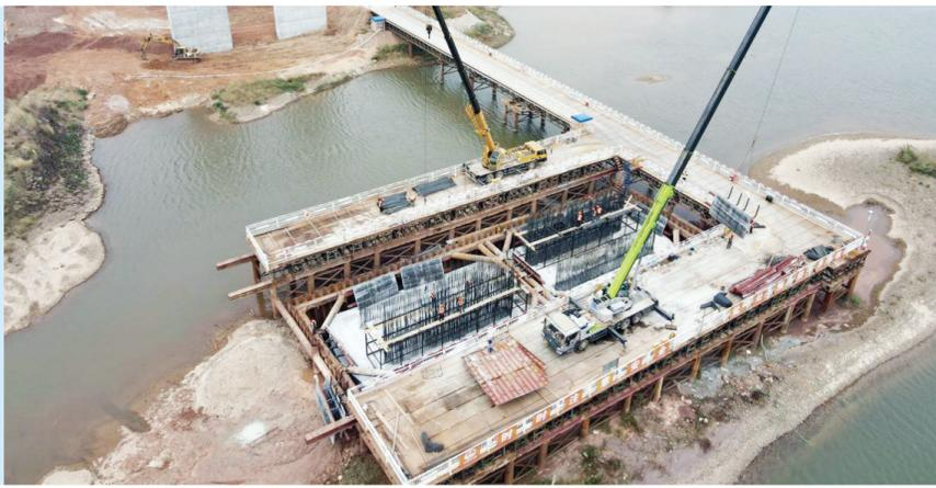
12月15日,由中铁一局承建的河涌G205改线工程临浦东江特大桥首个水中中墩墩基浇筑后,首个大体积主墩承台也顺利浇筑完成,为下一步桥梁工程的顺利推进奠定了坚实的基础。
