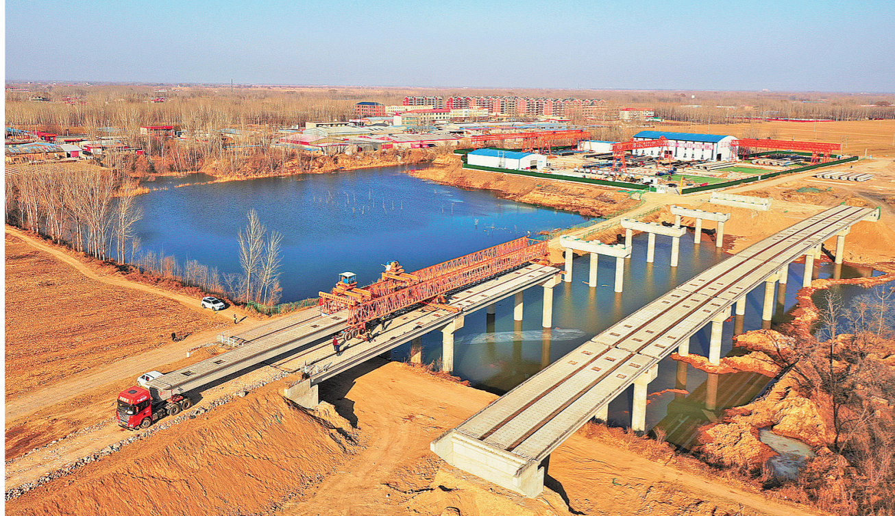
图为箱梁架现场。
