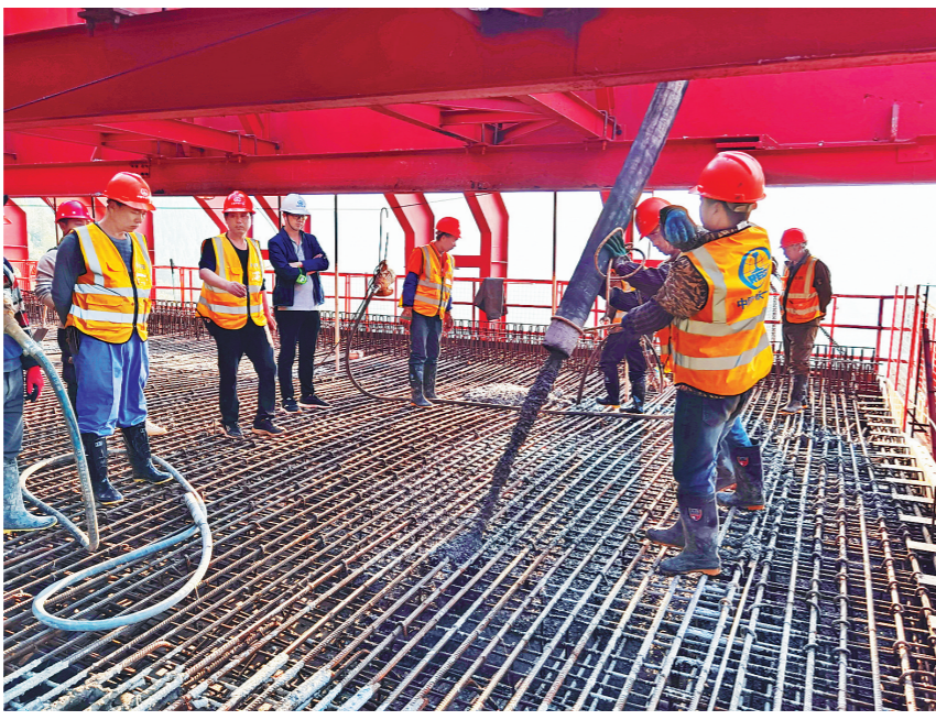
图为项目混凝土浇筑现场。
