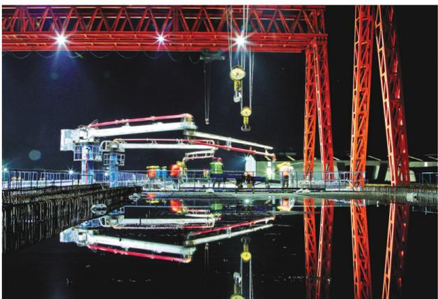
五一期间,新运公司南玉铁路制梁场作业人员正在对刚刚浇筑完成的箱梁用整平机收面。
