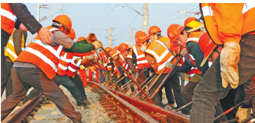
员工正在拨移道岔。
