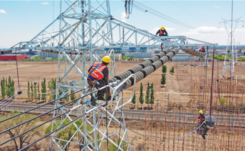
施工人员正在调整和紧固导线。 张品品 摄
