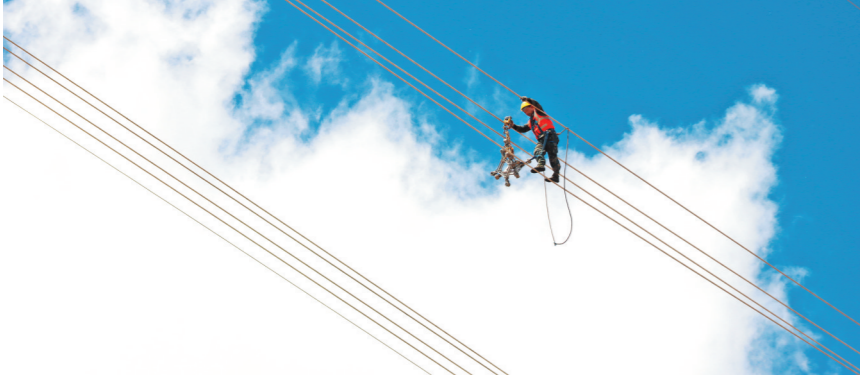
施工技术人员安装金具附件。 邓博予 摄
