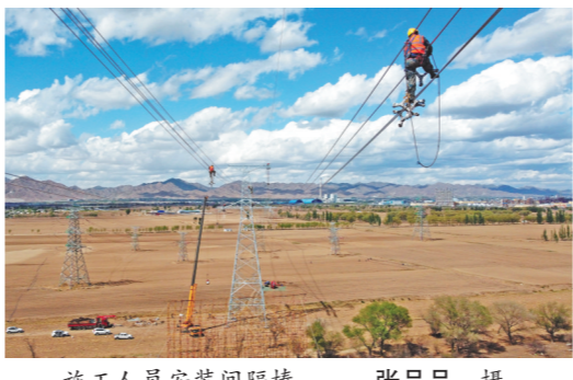
施工人员安装间隔棒。 张品品 摄
