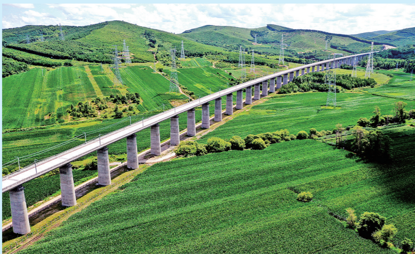
杜佳客专8标小安邦河2号特大桥。
