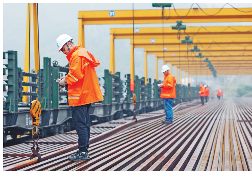
6月9日,刚刚参加完抢险任务的中铁一局贵南客专贵州段项目部员工又投入到紧张忙碌的施工生产当中。图为项目部员工在平昌铺轨基地冒雨吊卸500米长钢轨。截至目前,项目部累计进场500米长钢轨105公里。本报记者 黄斌 通讯员 李创新 截至高原 摄影报道
