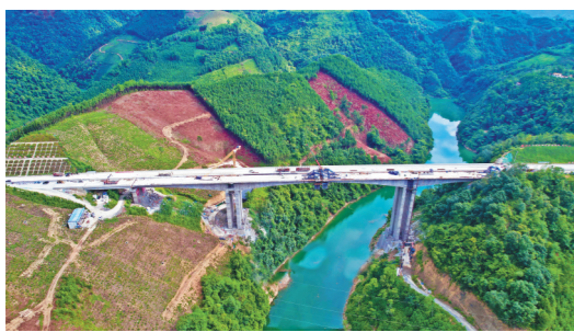
清水河刚构桥大桥双幅贯通。
