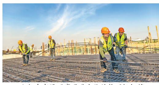
工人们在布设下穿通道主体结构顶板钢筋。
