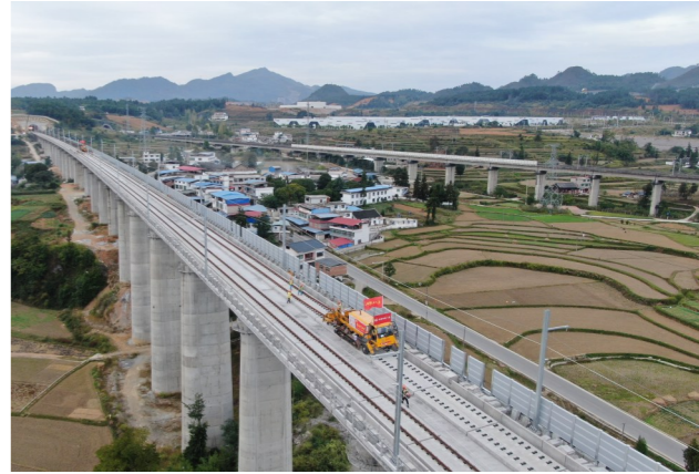
贵南高铁铺轨作业现场。
