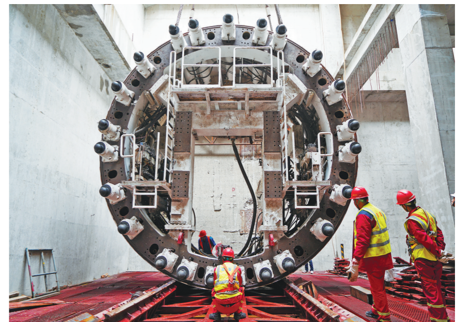
2月7日,随着起重机的全力启动,中铁一局城轨公司承建的上海18号线二期1标长江西路站首台盾构机中盾缓缓下沉入井,这标志着长江西路站~江杨南路站盾构左线区间工程进入新阶段。 通讯员 王靖隆 摄影报道
