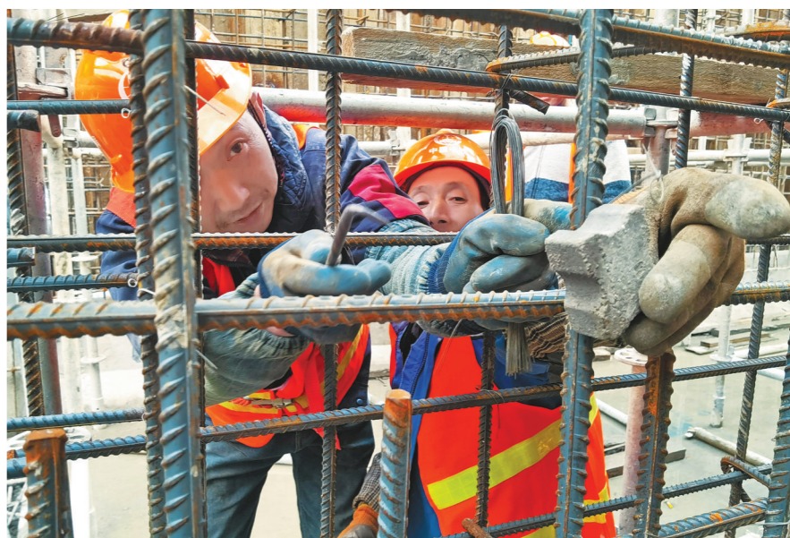
无锡地铁4号线二期工程锡士路车站电力隧道工程是中铁一局城轨公司首个电力隧道项目。目前项目以每日4根灌注桩、40根钢板桩、8米TRD速度快速推进,安全、质量全面受控。图为工人在对主体结构绑扎钢筋。
