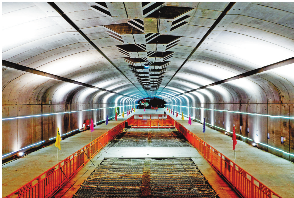
富春江站地铁车站全景。
