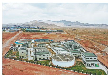
图为竣工后的污水处理厂全貌。
