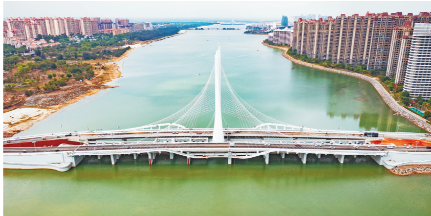
通车后的海花岛跨海2号桥。
