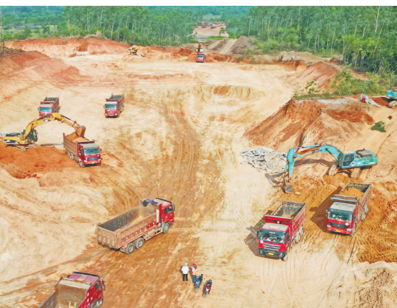
图为项目施工大干现场。 本报记者 牛荣健 摄
