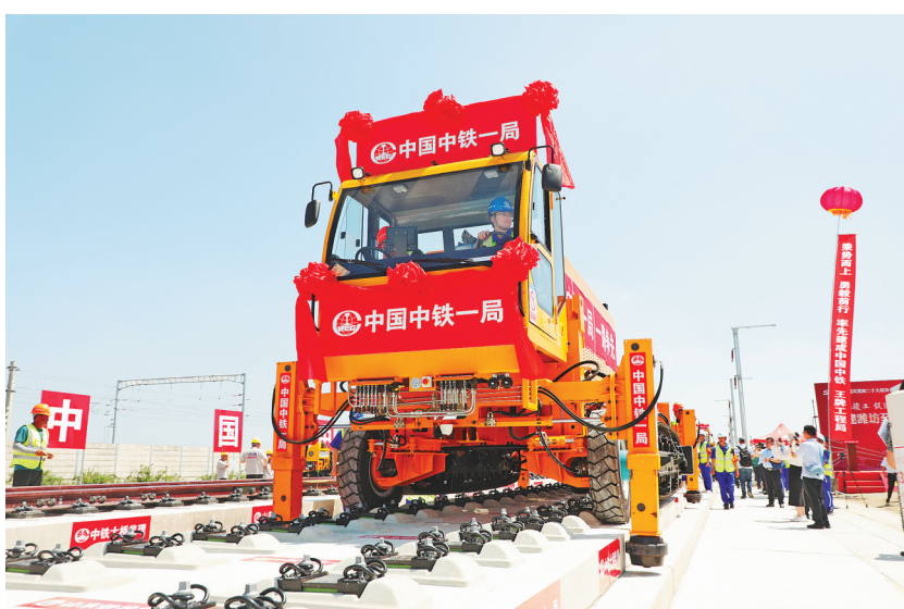
潍烟铁路开始全线铺轨。
