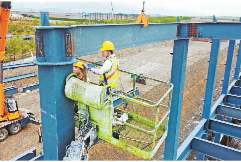
近日,在三公司乌苏市物流仓储基地建设项目施工现场,6支施工队伍,100多名工人正在各自的岗位上奋战,汗水湿透的衣背和坚定而专注的表情,彰显出他们对施工生产的高度投入和奋斗状态。图为钢结构施工现场。通讯员 雷富财 尚志远 摄影报道
