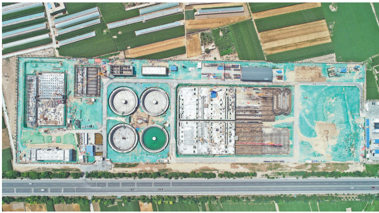
凉州污水处理厂施工全景。
