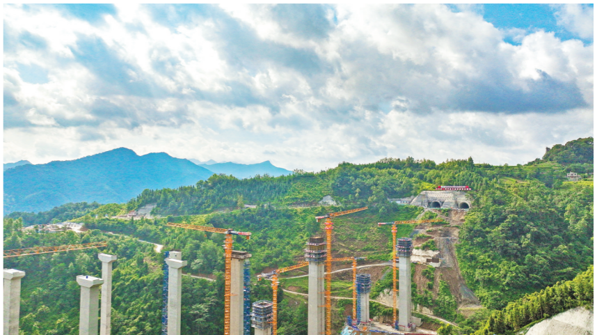
中铁一局三公司施工的的乐望高速公路喜达隧道右幅7月25日贯通。至此,项目10座隧道已完成8座隧道的贯通。 通讯员 马子杰 摄影报道
