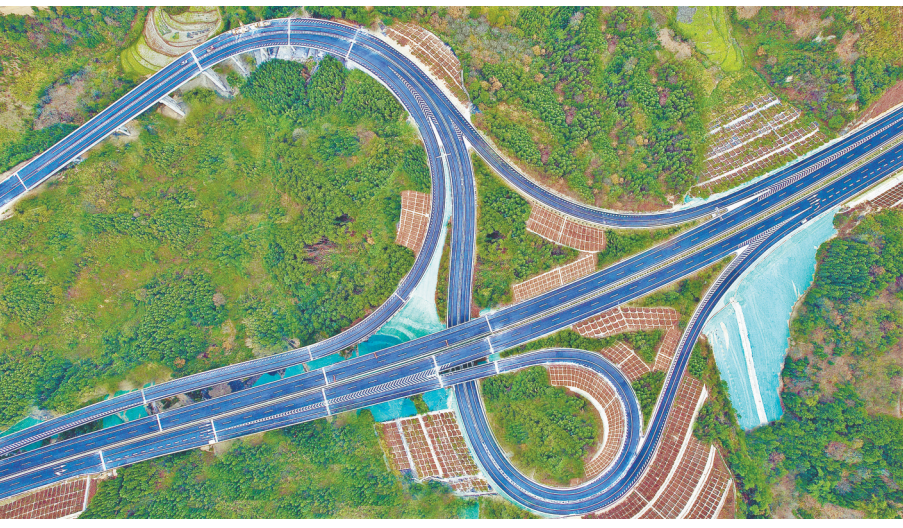
中铁一局三公司参建的广西南天高速为广西在建高速公路建设项目桥梁跨度最大、隧道单洞最长的项目。
