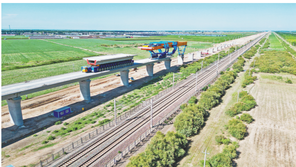
包银高铁包银段站前5标中铁一局项目架梁。
