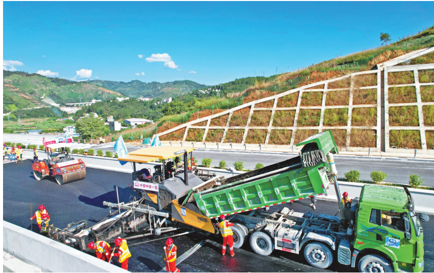
10月15日,在中铁一局一公司隆林委委至单步高速公路一期工程路面施工现场,伴随着沥青摊铺机工作的轰鸣声,沥青混凝土下面层摊铺施工正式开始。
