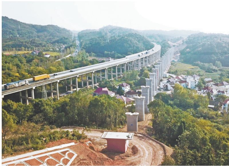
10月15日,中铁路一局昌九高铁CJZQ-1标程家畷特大桥南昌台最后一方混凝土浇筑完成,至此,大桥下部结构施工全部完成。程家畷特大桥位于九江市濂溪区,桥梁全长732.05米,设计桩基248根,墩台24个,桥台采用矩形空心桥墩,桥墩采用圆形实体墩。首根桩基于2022年11月18日开始浇筑,至下部结构全部施工完成共用时332天。
