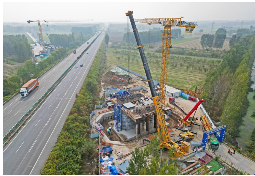
10月23日,随着重达85吨钢支墩装入跨大广高速矮塔斜拉桥主墩,中铁路一局雄商高铁站前一标项目正式转入上部结构施工,保障了后续施工节点。
