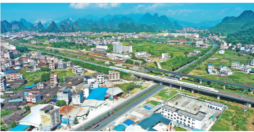
黄田至姑婆山公路升级改造工程施工现场鸟瞰图。
