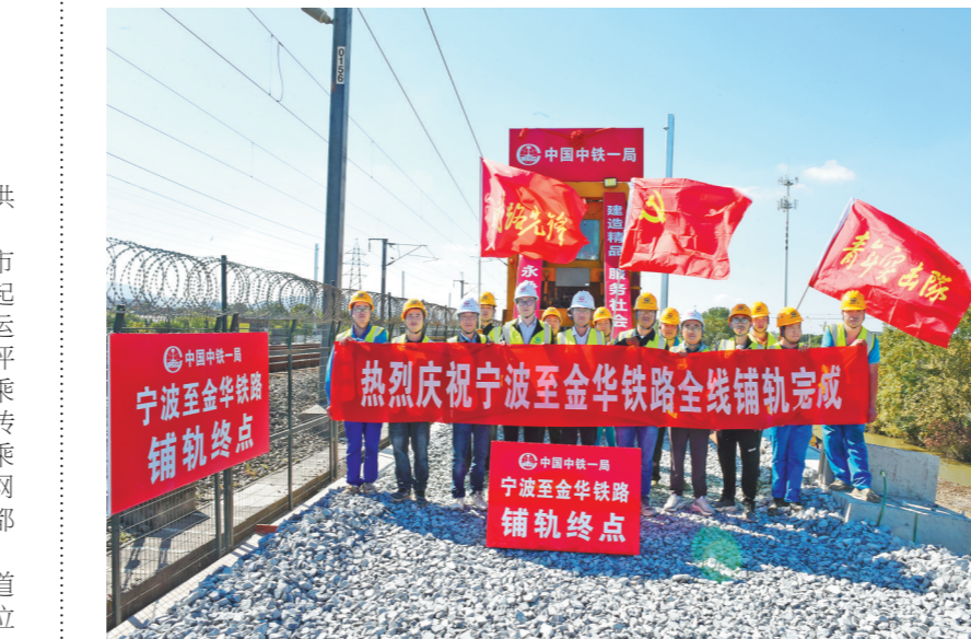
甬金铁路全线铺轨完成。
