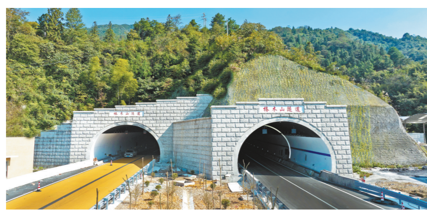
中铁一局施工的椿木山隧道洞口。
