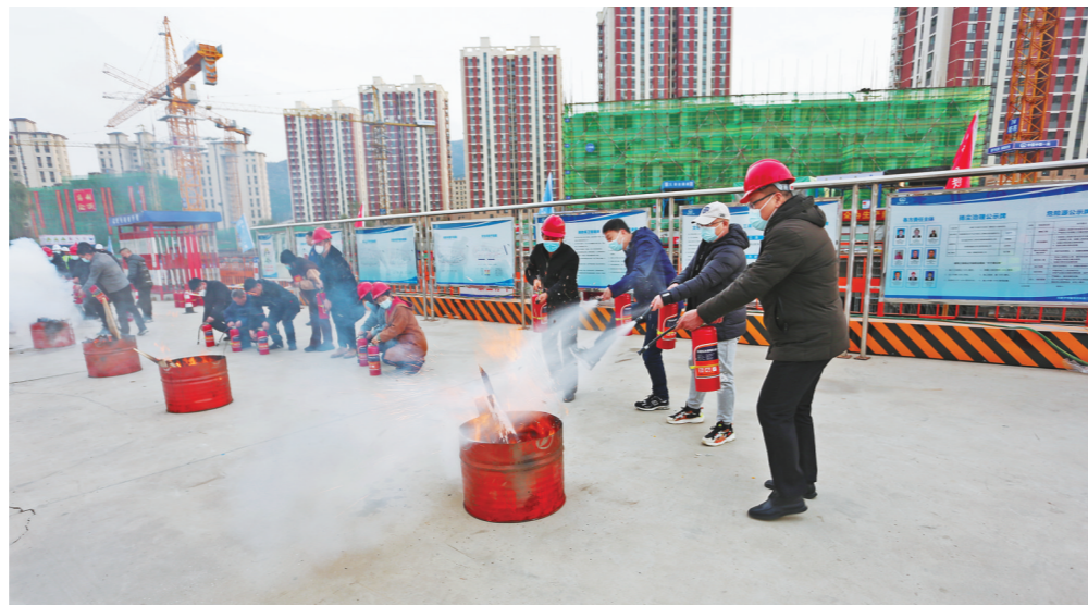
11月15日，中铁一局冯管子村城中村改造二期回迁B地块项目部举行承德市住房和城乡建设局机关消防培训暨重点领域消防应急演练、观摩会。此次演练旨在通过模拟真实火灾场景，让员工亲身体验火灾逃生的紧迫感和压力，提高应变能力，培养沉着冷静应对突发事件的能力。图为现场使用灭火器。
