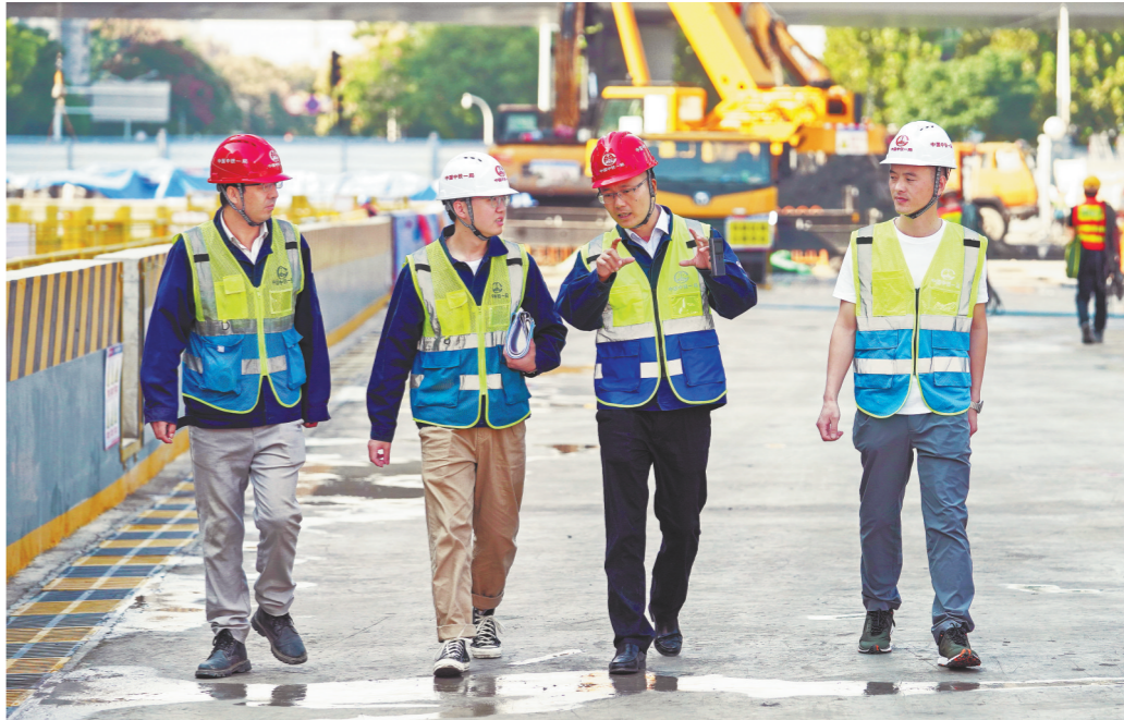
刘奇(右二)在武汉地铁12号线建设现场。
