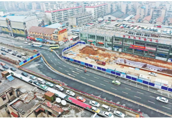
“加盖子”后的中山路下穿隧道(资料图)。
