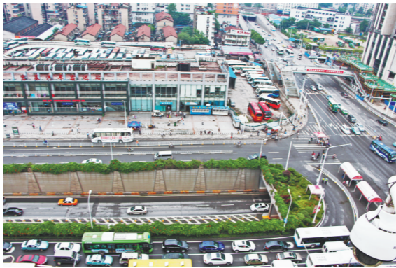
中山路下穿隧道。
