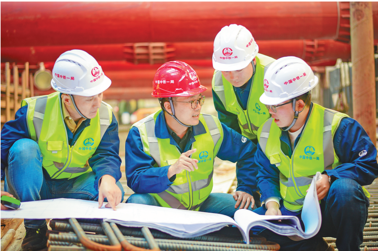
刘奇(中)在施工现场。
